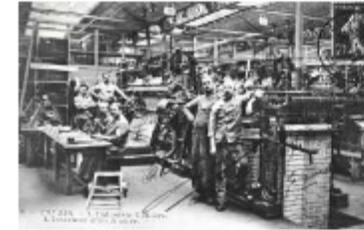
Appelés les seigneurs de la dentelle, les tullistes assurent la fabrication de la dentelle en effectuant les derniers réglages sur le métier Leavers, en le faisant fonctionner et en surveillant les fils qui cassent.
